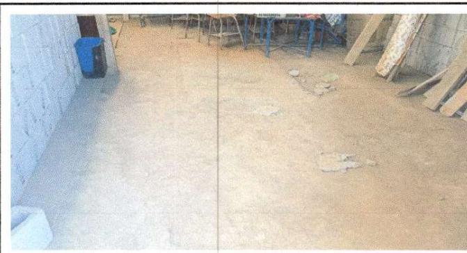
Foto 4: Sustitucion de piso de torta de concreto
