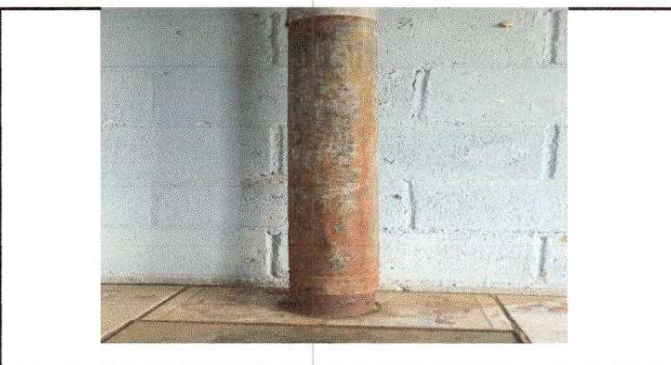
Foto 6: Sustitución de chimenea de concreto
