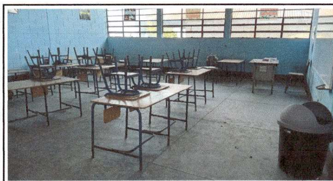
Foto 5: Sustitución de piso cerámico.
